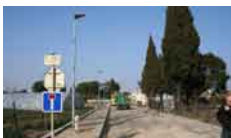
Chemin St Michel (éclairage public effacement des réseaux)
