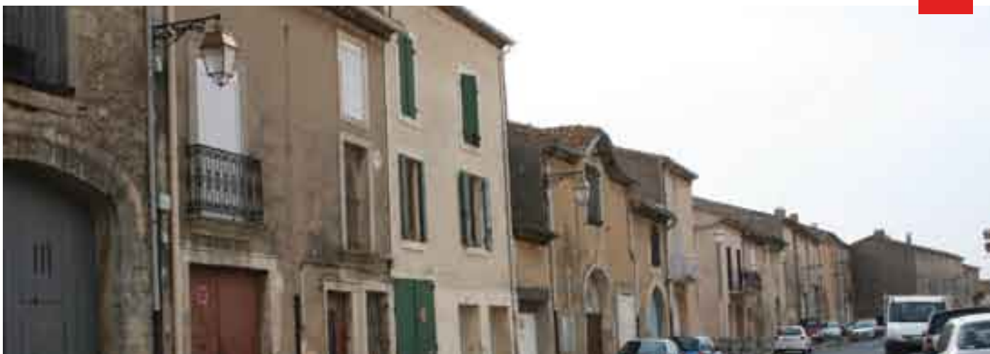
Boulevard F. Mistral : pose de consoles d'éclairage public
