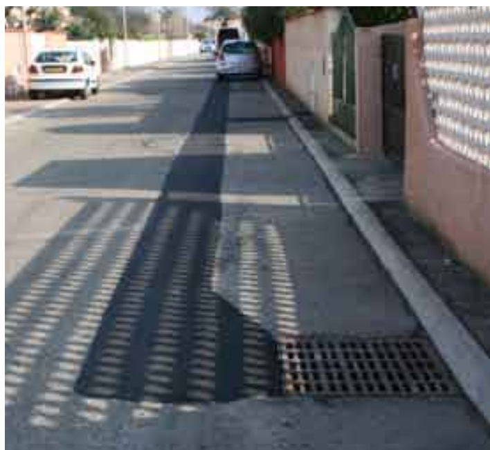
Amélioration du réseau pluvial rue de l'Occident
