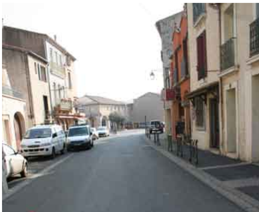
Effacement du réseau boulevard de la République et pose de mobilier urbain
