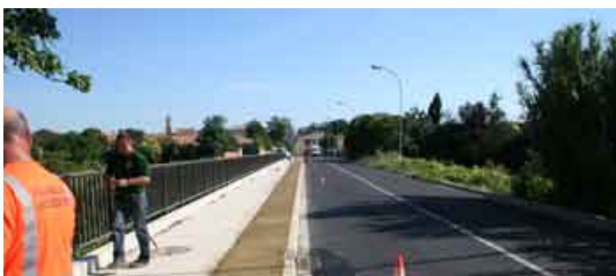
Trottoirs et espaces verts route de Sérignan (Création)
