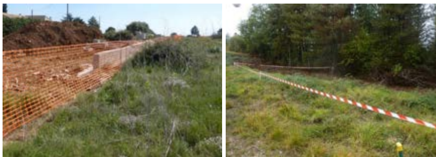
Exemples de balisage : à gauche, grillage souple de chantier ; à droite, rubalise sur piquets – CBE
