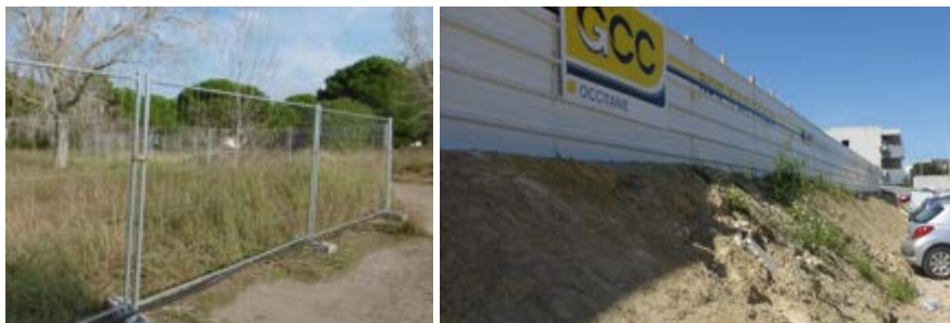
Exemples de balisage : à gauche, barrières de type 'Héras' ; à droite, barrière de chantier - CBE
